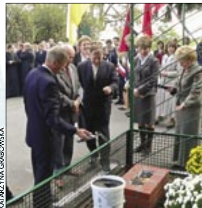
Samorządowcy i dyrekcja szkoły wmurowali kamień węgielny pod budowę sali sportowej
