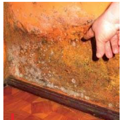
Niemal wszystkie ściany opanował grzyb. Na zdjęciu jedno z mieszkań na pierwszym piętrze
