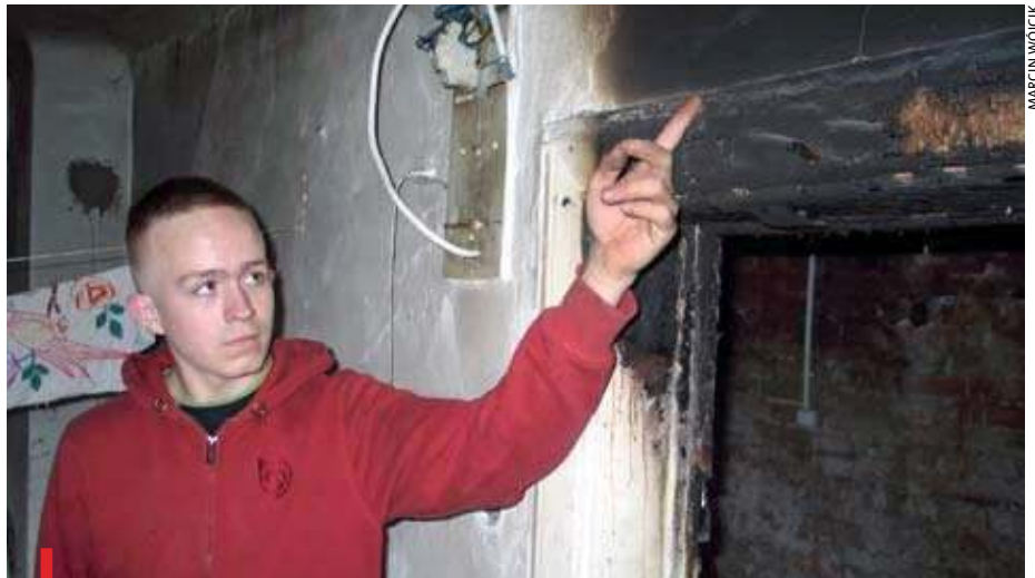
Fabian pokazuje spaloną część kamienicy. Po dwóch latach od pożaru wciąż straszą nieuprzątnięte zgliszcza
