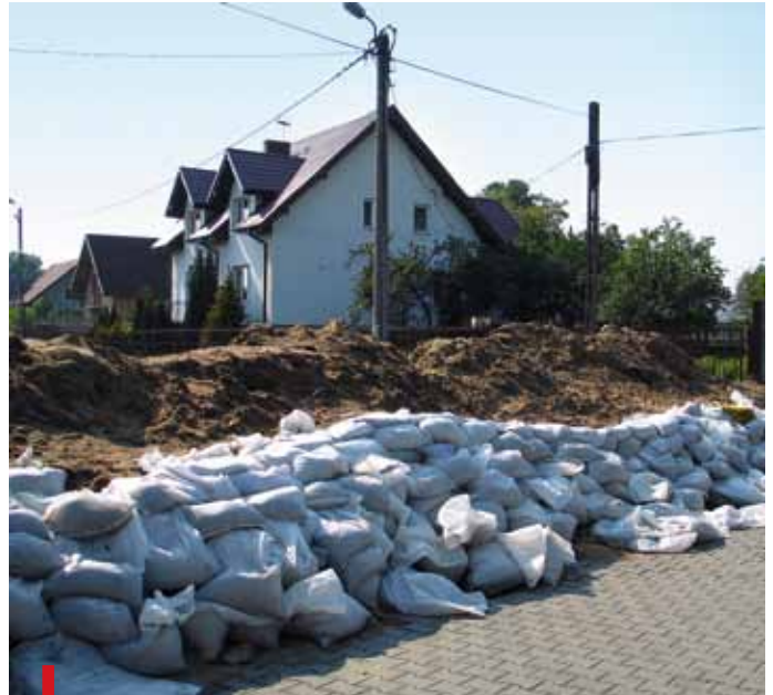
Jeśli nie ma wałów przy korytach rzek, trzeba je później budować na ulicach. Na zdjęciu Głowno, ul. Robotnicza
