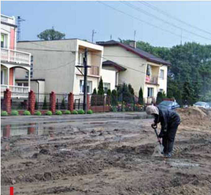
Mirosława Walichmowska z ul. Złotej w Głownie odprowadza wodę z drogi. Jak widać na zdjęciu – sprawnej kanalizacji brak
