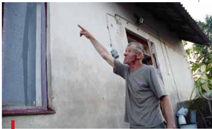
Na ścianach domów jeszcze długo będzie widać poziom, jaki osiągnęła woda
