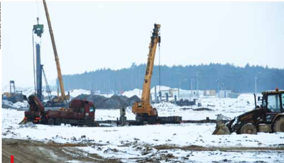
DZIERZGÓW, 27 STYCZNIA. W wielu miejscach na terenie diecezji łowickiej trwa budowa autostrady A2
