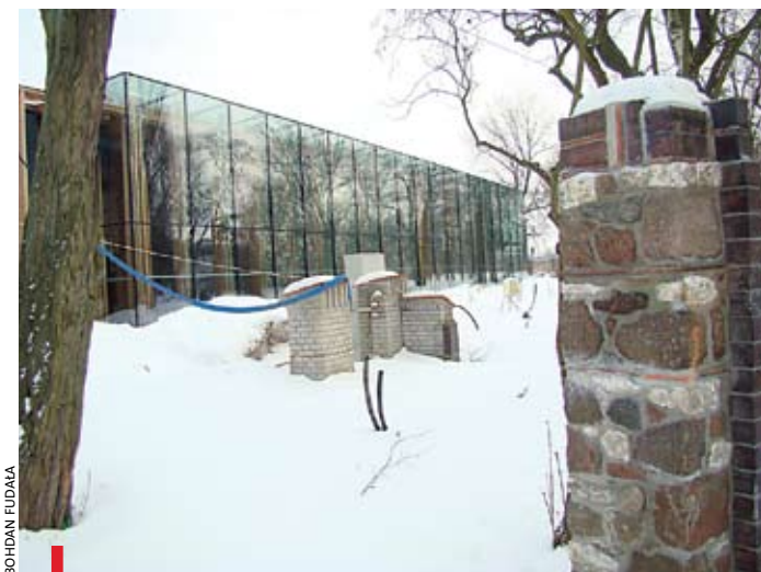
Budowę przeszklonych pawilonów w Żelazowej Woli przerwała zima
