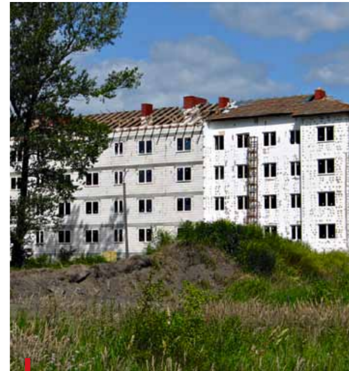
W Łowiczu przy ul. Włódzkiej powstaje blok komunalny dla 52 rodzin. Ma być oddany do użytku jesienią tego roku
